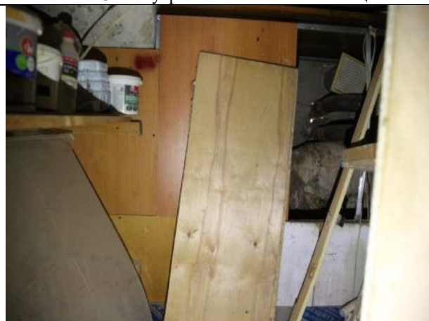
Фото № 10 – Внутреннее состояние помещения
