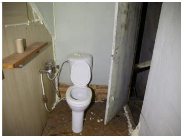
Фото № 16 – Внутреннее состояние помещения
