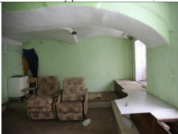
Фото № 27 – Внутреннее состояние помещения
