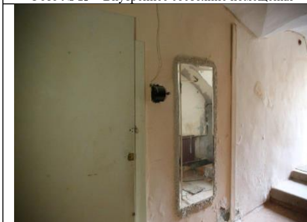
Фото № 21 – Внутреннее состояние помещения
