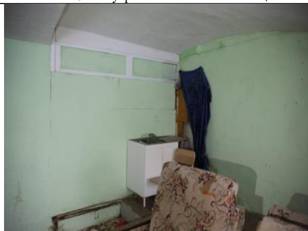
Фото № 28 – Внутреннее состояние помещения
