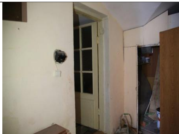
Фото № 8 – Внутреннее состояние помещения
