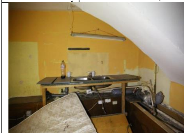
Фото № 13 – Внутреннее состояние помещения
