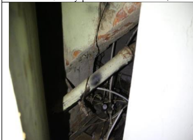
Фото № 17 – Внутреннее состояние помещения
