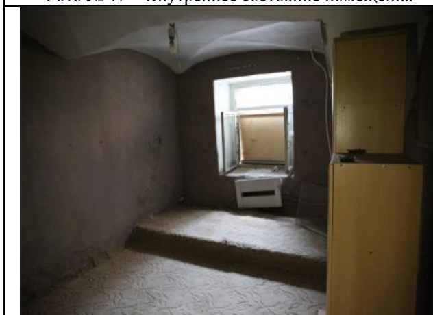
Фото № 19 – Внутреннее состояние помещения
